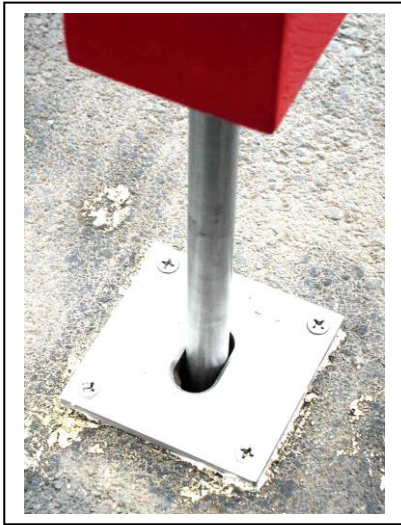
Detail Bodenplatte für Bodenverriegelung bei händischem, zweiflügeligem Drehtor
