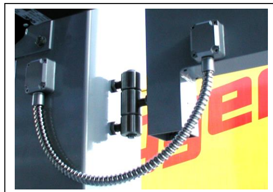
Detail Überbrückschutz vom Drehtorflügel zur Torsäule; Band: verstellbares Nirostaband
