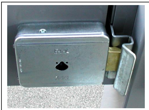
Detail Elektroschloss mit Seiten- schließblech am unteren Drehtorrahmen
