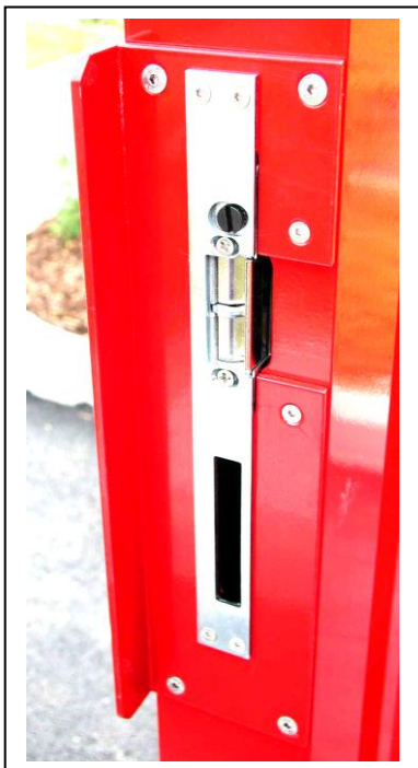
Detail Drehtoranschlag mit Elektro-Öffner
