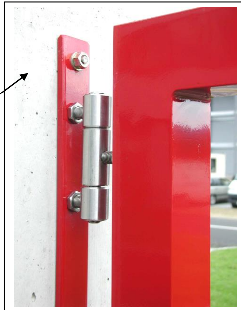
Abb. Drehtor-Banddetail: 3-teiliges, verstellbares Nirostaband
