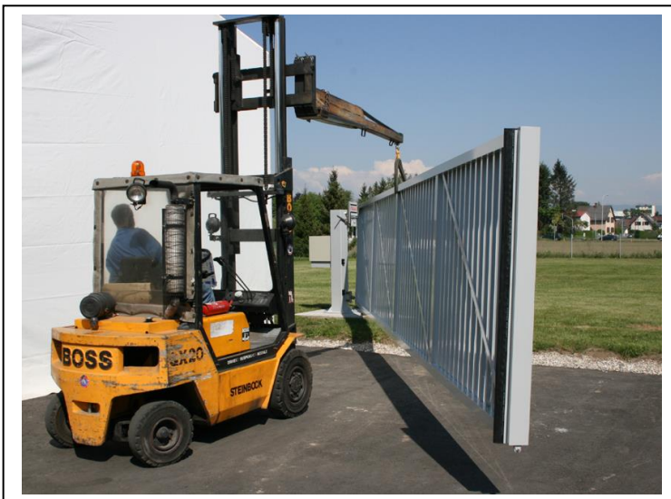
Einführen der Gewindebolzen in die dafür vorgesehenen Langschlitze im Torflügel.
