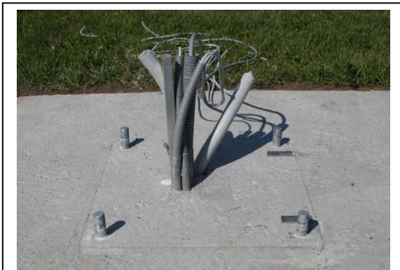
Abb. eingeklebte Ankerstangen zur Befestigung der bandseitigen Säule mit mittigen Elektroauslässen
