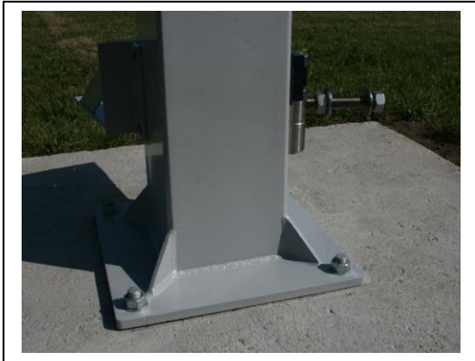
Aufsetzen der Säule
