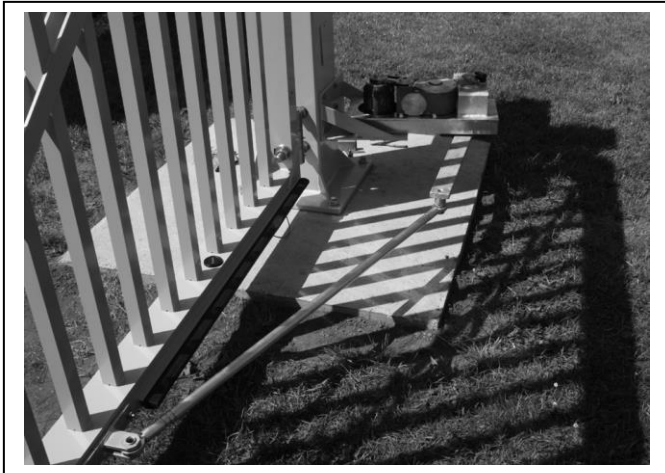
Abb. Aufgeschraubter Motorantrieb mit Motorarm und Gestänge
