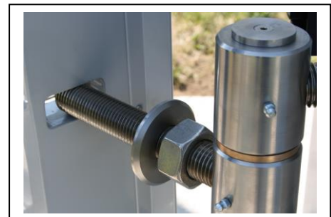
Einführen der Gewindebolzen in die dafür vorgesehenen Langschlitze im Torflügel.
