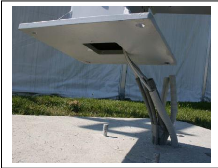
Aufsetzen der Säule
