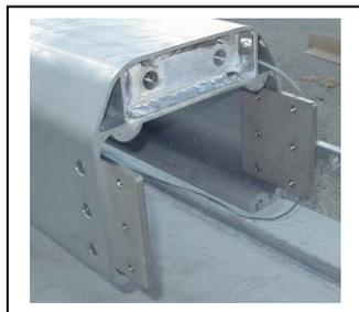
Verbindungsplatten unten am Schiebetor-Laufprofil
