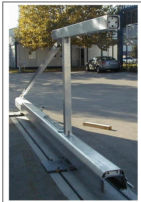
13. Verschrauben des vorderen Torteiles mit dem bereits aufgeschobenem rückwärtigen Torteil mit den beige-packten Verbindungsschrauben und Verbindungsplatten.
