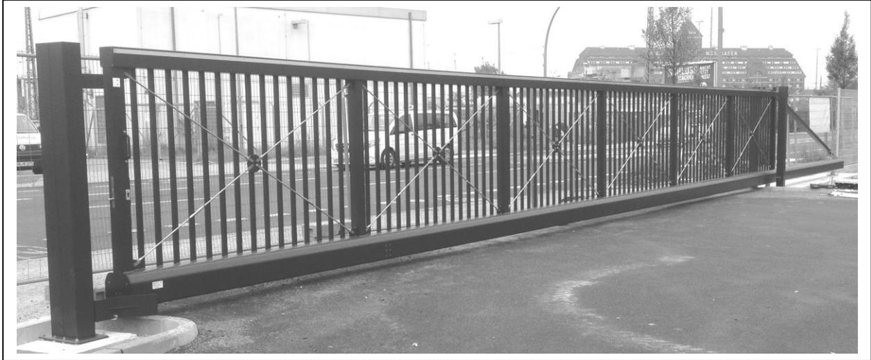
Die Leichtgängigkeit des Schiebetores ist nach beendeter Montage nochmals im entriegelten Zustand zu überprüfen! (Siehe Merkblatt „Notentriegelung“)
